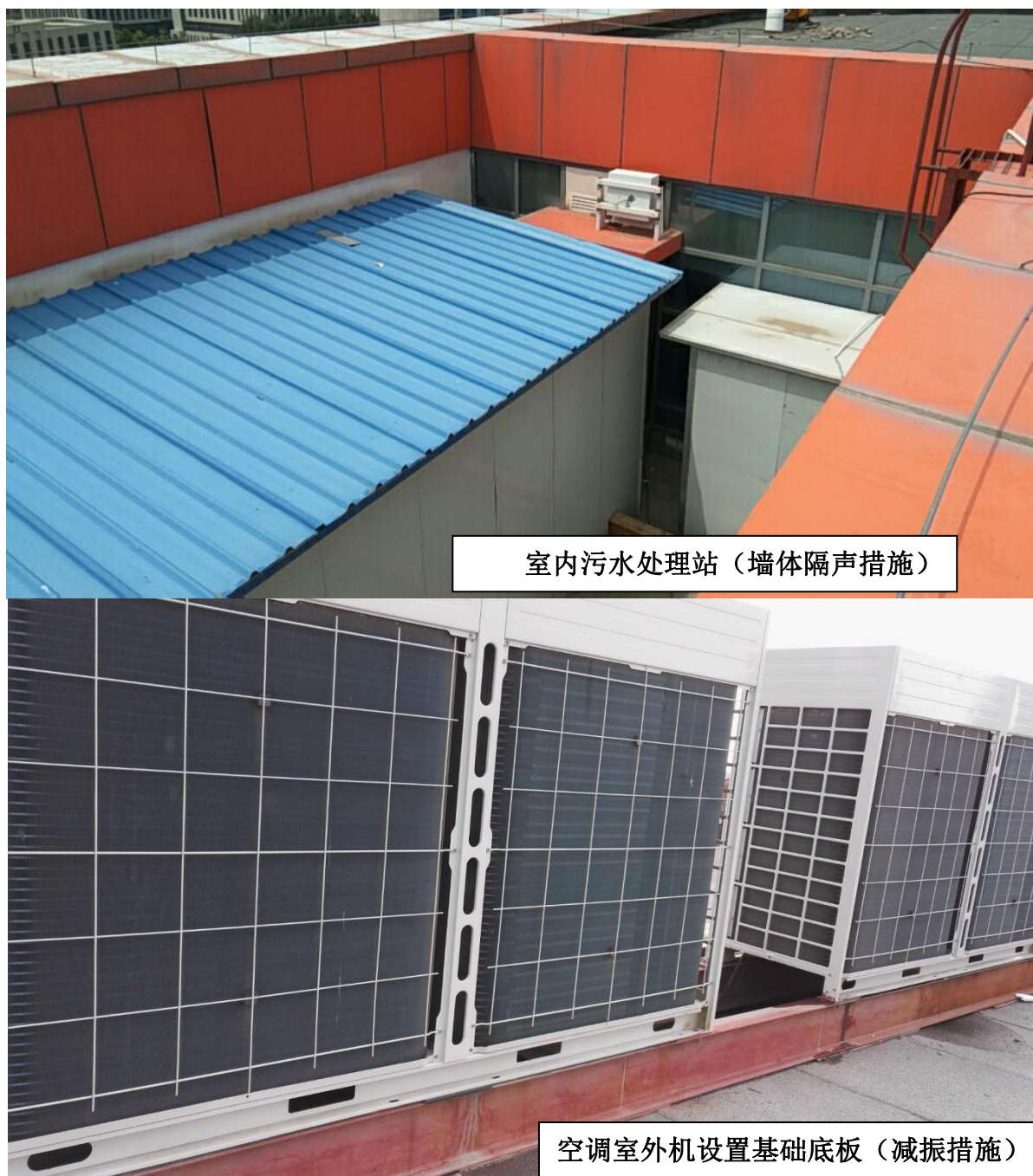
图 7-3 项目部分噪声防治措施现状图
