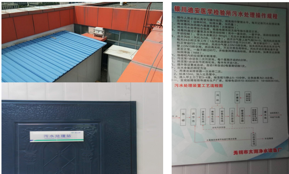
图 7-4 项目污水处理站局部现状图
